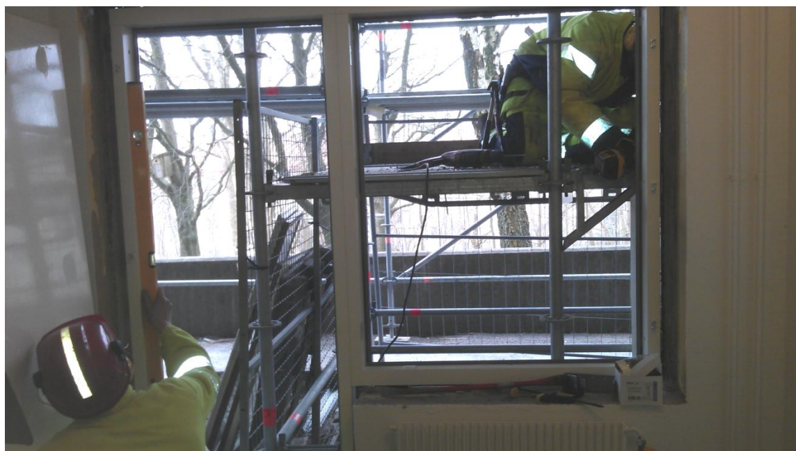
Bild 2: Yrkesarbetarna utför montering av fönster. foto: (K.Flodin, 2012)
