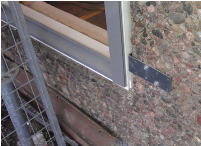
Bild 5: Speciella vinkeljärn för montering av fönster, foto: (K.Flodin, 2012)
