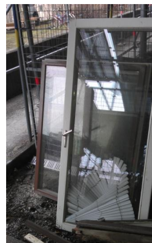
Bild 4: Demonterat fönster. foto: (K.Flodin, 2012)
